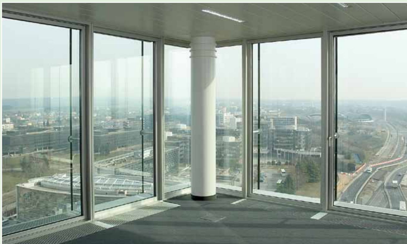
Vue d'un bureau: plafond refroidissant et ventilation source
