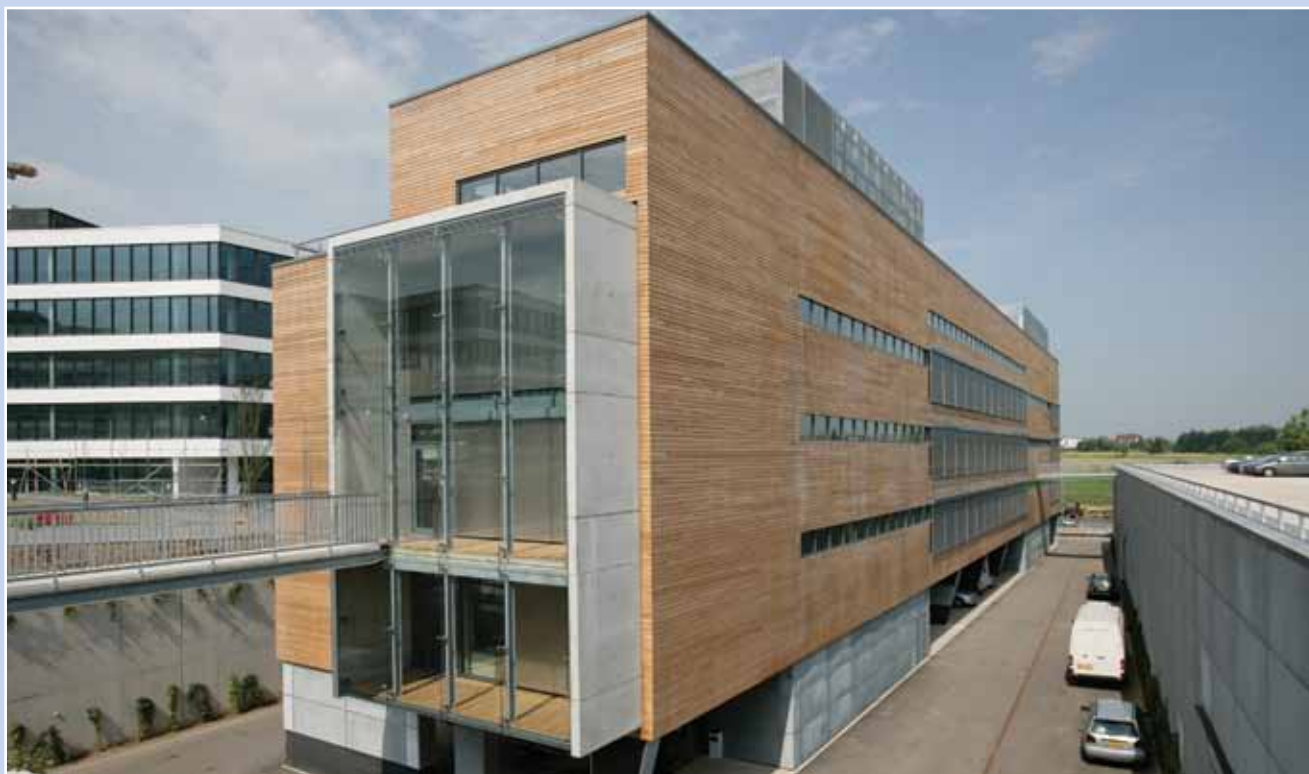
Nouveau siège de A+P KIEFFER OMNITEC à Cloche d'Or
