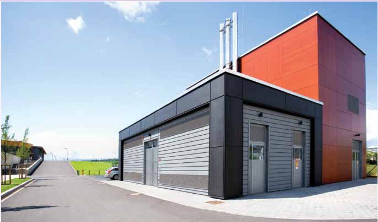
Centrale de cogénération "op Acker" à Bascharage
