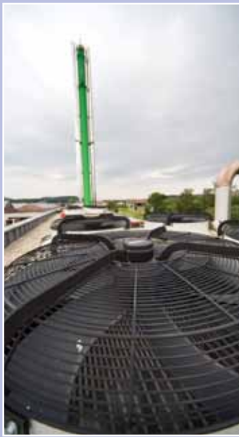
Refroidisseurs de secours des BHKW et des moteurs Diesel
