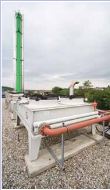
Refroidisseurs de secours des BHKW et des moteurs Diesel
