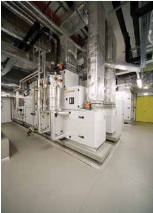
Groupe de ventilation hygiénique pour salles d'opération
