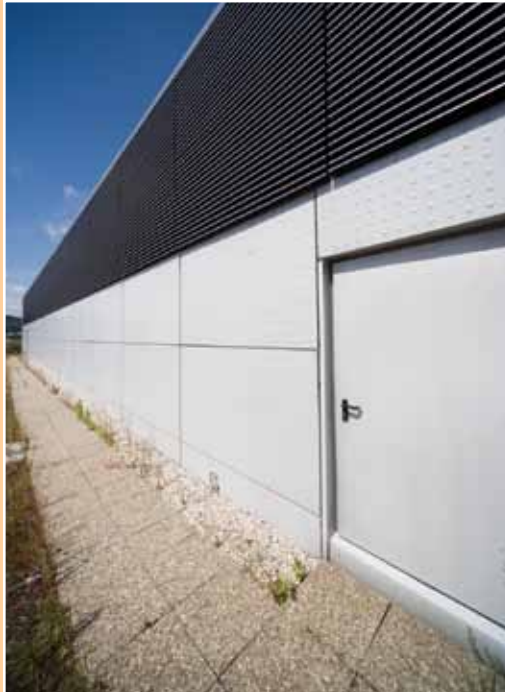
Prise d'air extérieure
