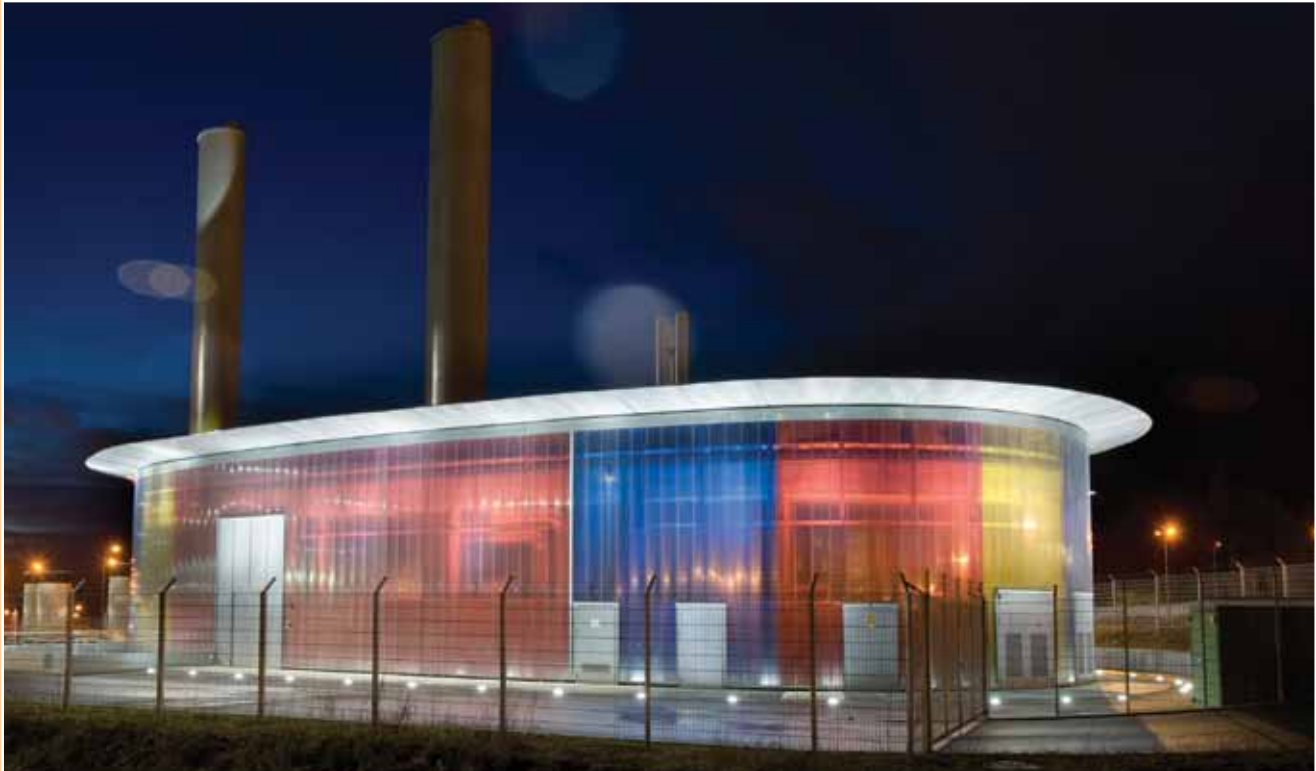
Vue extérieure de la centrale de cogénération
