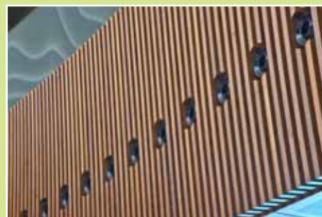
...est ventilée entre autres par des buses à jet de longue portée
