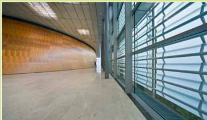
Le confort du foyer est assuré par chauffage sol, une façade avec sa structure climatisée et des poutres refroidissantes
