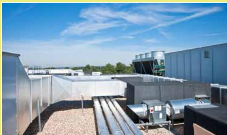
Techniques sur la toiture avec le container « froid » et tour hybride
