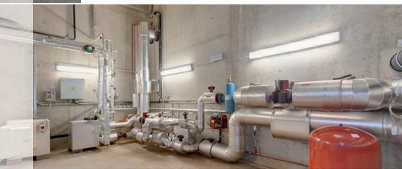
Raccordement de l'échangeur au réseau de chauffage urbain
