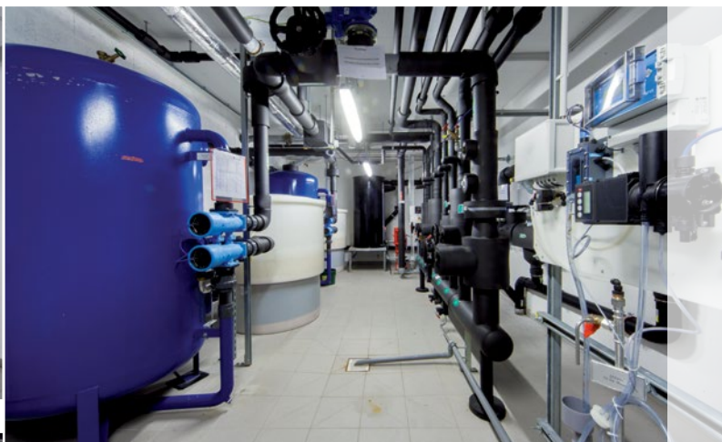
Adoucisseur d'eau et traitement de l'eau sanitaire
