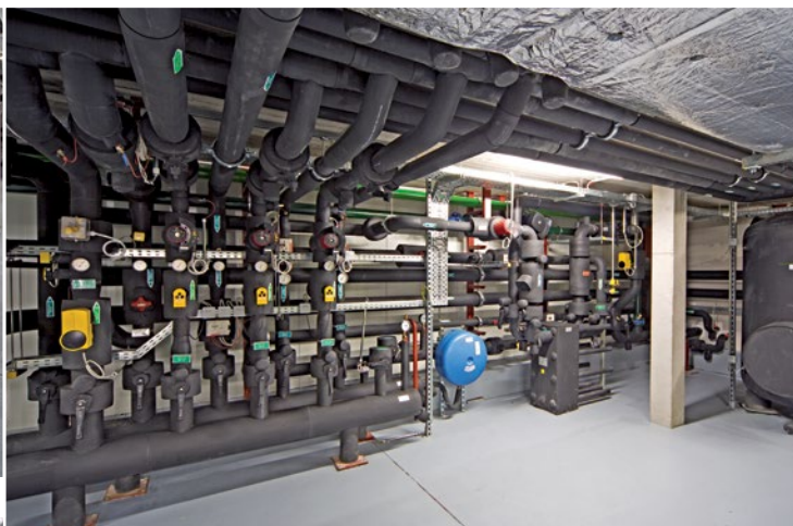
Local technique 2° étage / collecteur froid
