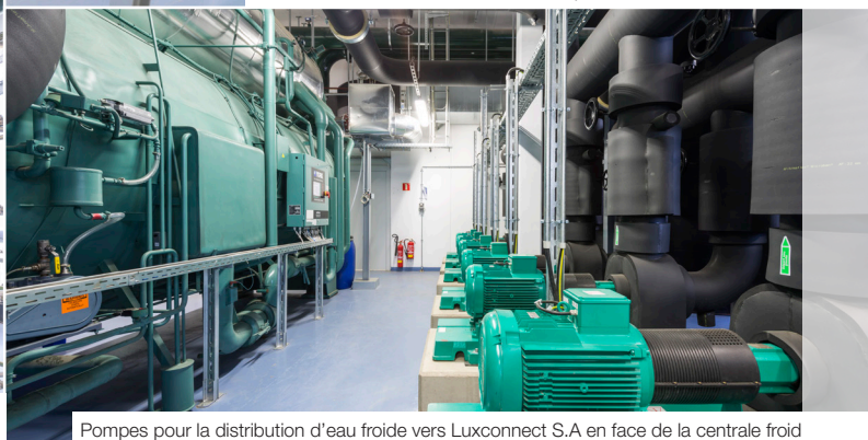
Production froid : 2 x machines à absorption de 2 500 kW chacune
