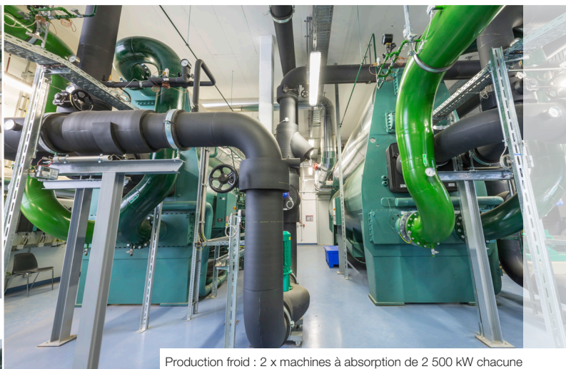
Production froid : 2 x machines à absorption de 2 500 kW chacune
