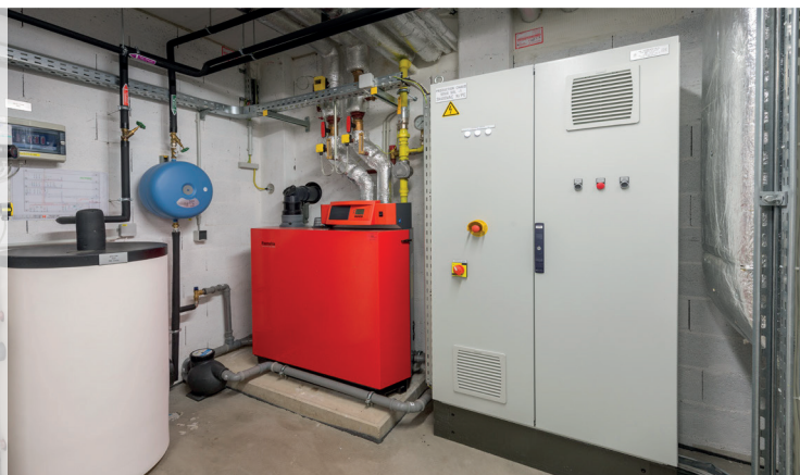
Chaudière à condensation
