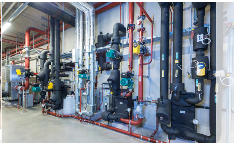
Centrale technique bâtiment A
