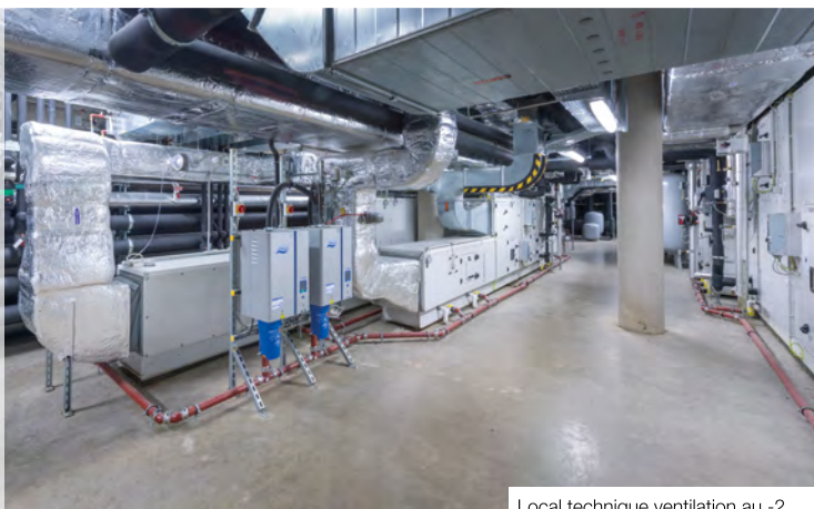
Local technique ventilation au -2
